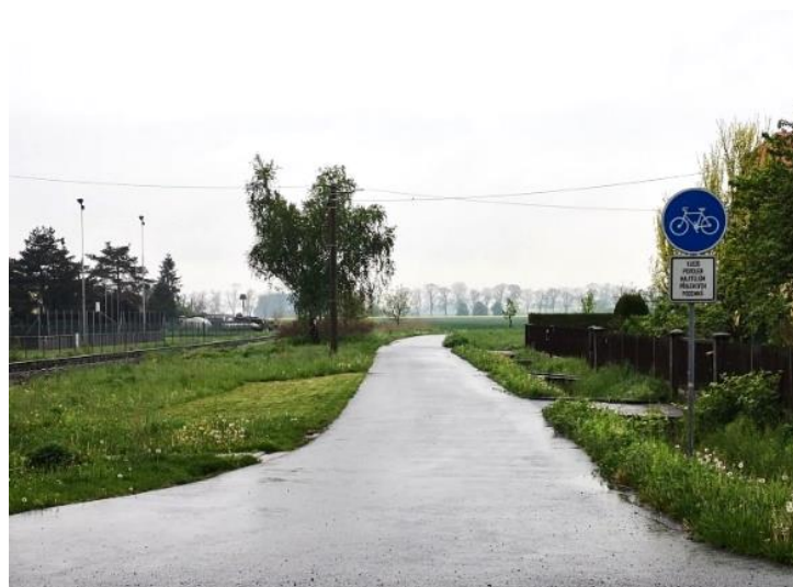
Obr.1 Dolní Benešov – vjezd na účelovou komunikaci
